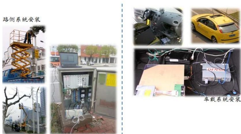
Figure 18 l'installation et le débogage des équipements de l'unité de bord de route
