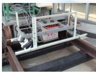
城市轨道交通轨道检测基地
